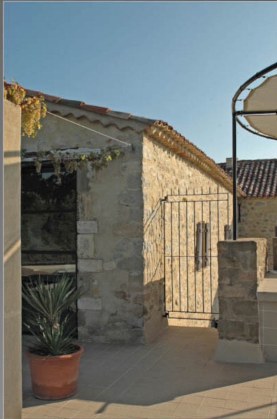
de la cuisine extérieure je peux rejoindre le patio
