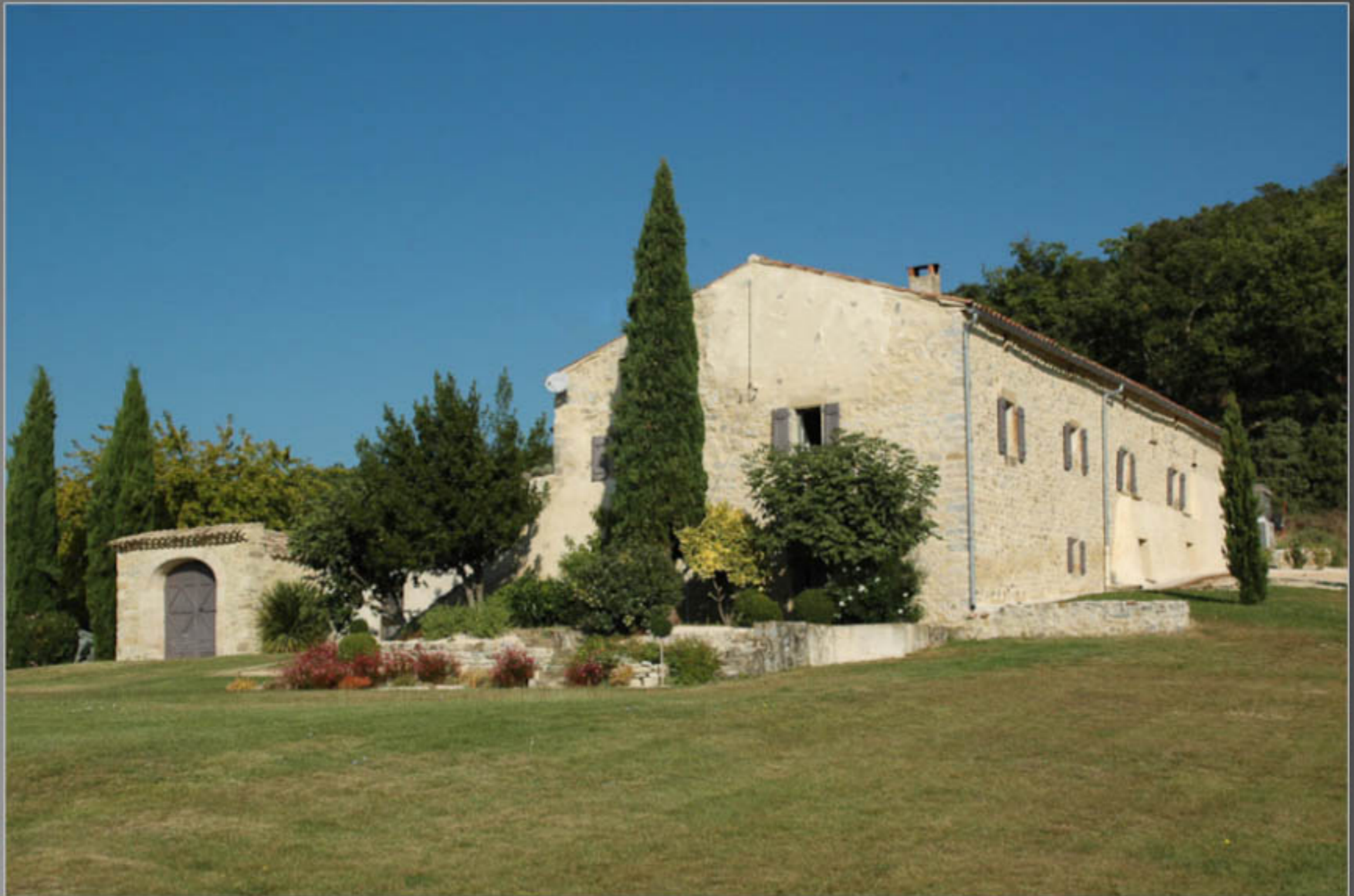
pignon sud et façade Est des bâtiments qui donne accès à l'arrière du mas et la cuisine
